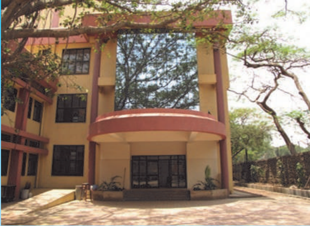
एन. आई. यू. एस. भवन NIUS Building
